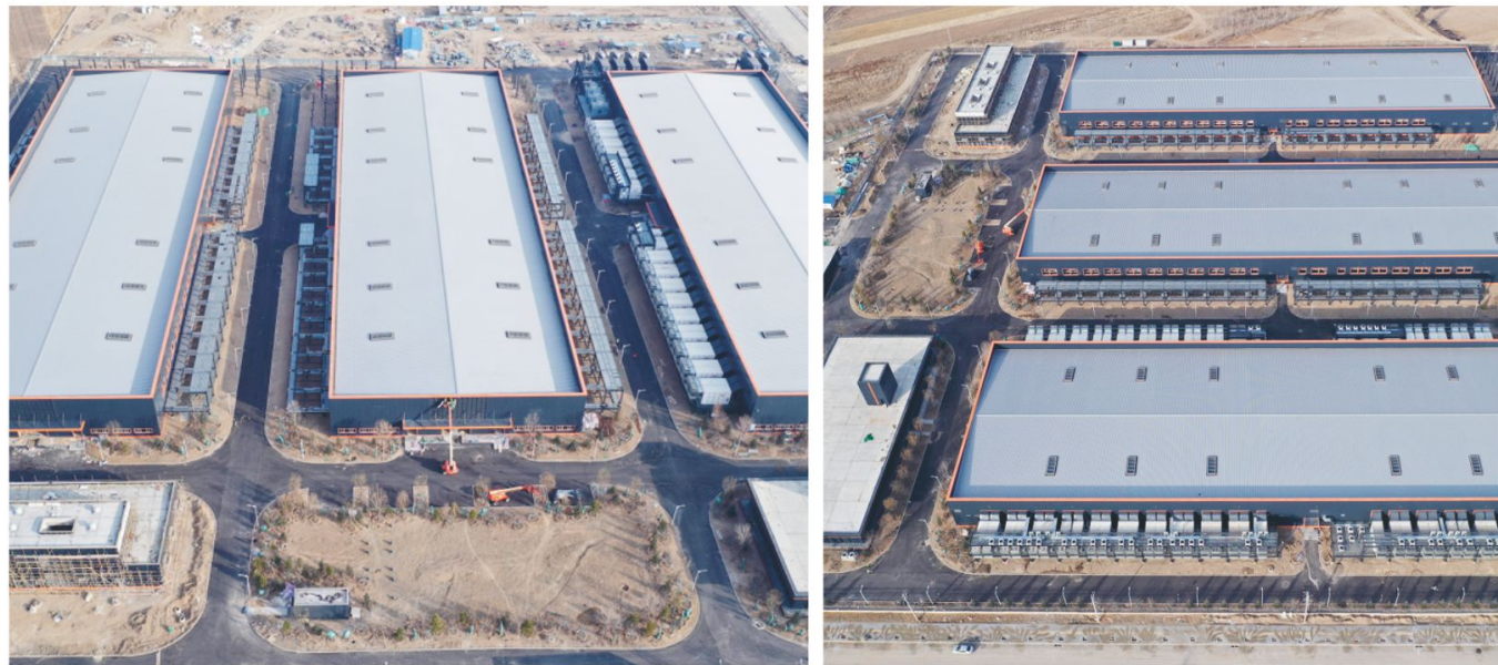
华为乌兰察布数据中心 Huawei Ulanqab Data Center
