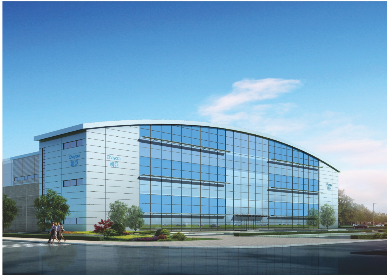
天津朝亚数据中心 Chayora (Tianjin) Data Center
