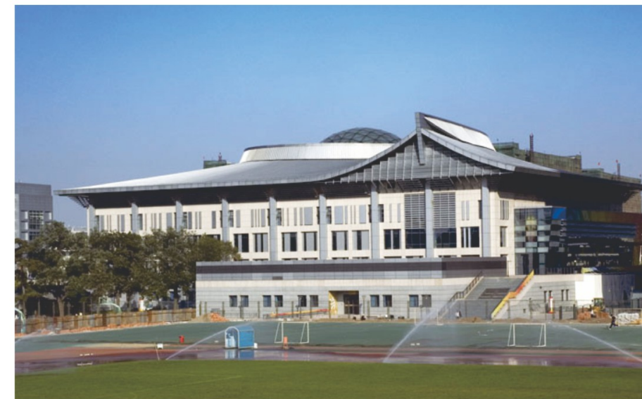
北京大学体育馆 Peking University Gymnasium
