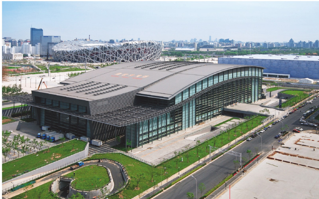
国家体育馆 National Indoor Stadium
