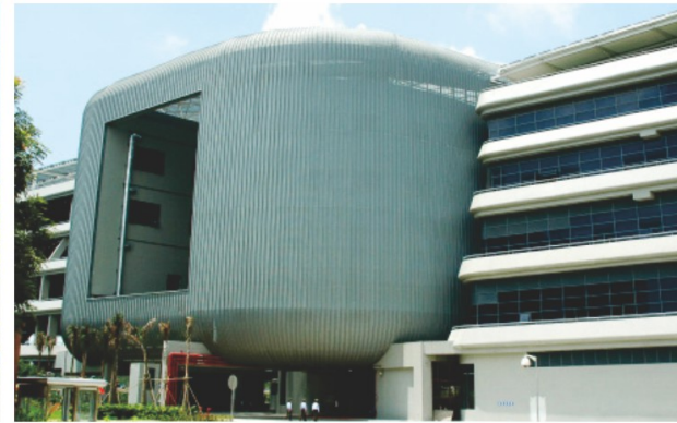
深圳福田客运枢纽中心 Shenzhen Futian Passenger Transportation Center
