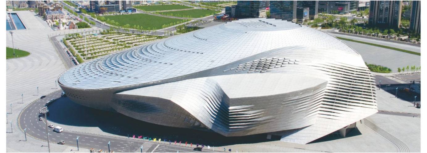
大连国际会议中心 Dalian International Conference Center
