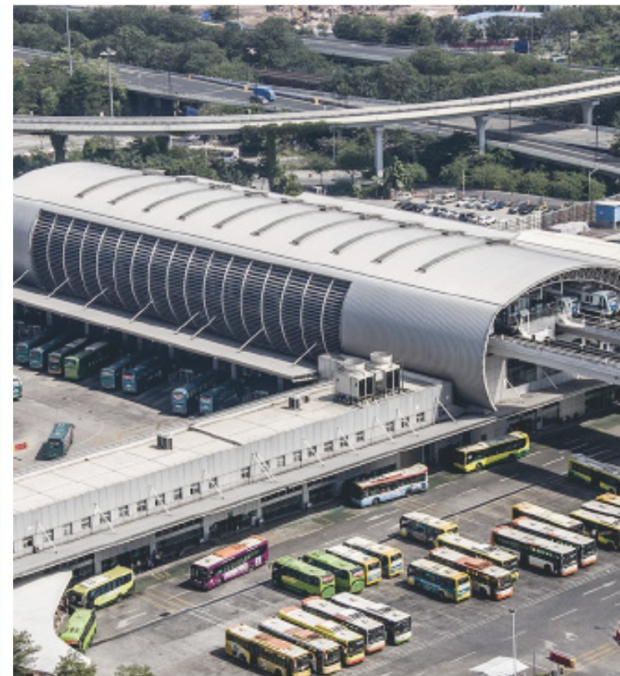
广州地铁五号线 Guangzhou Metro Line 5
