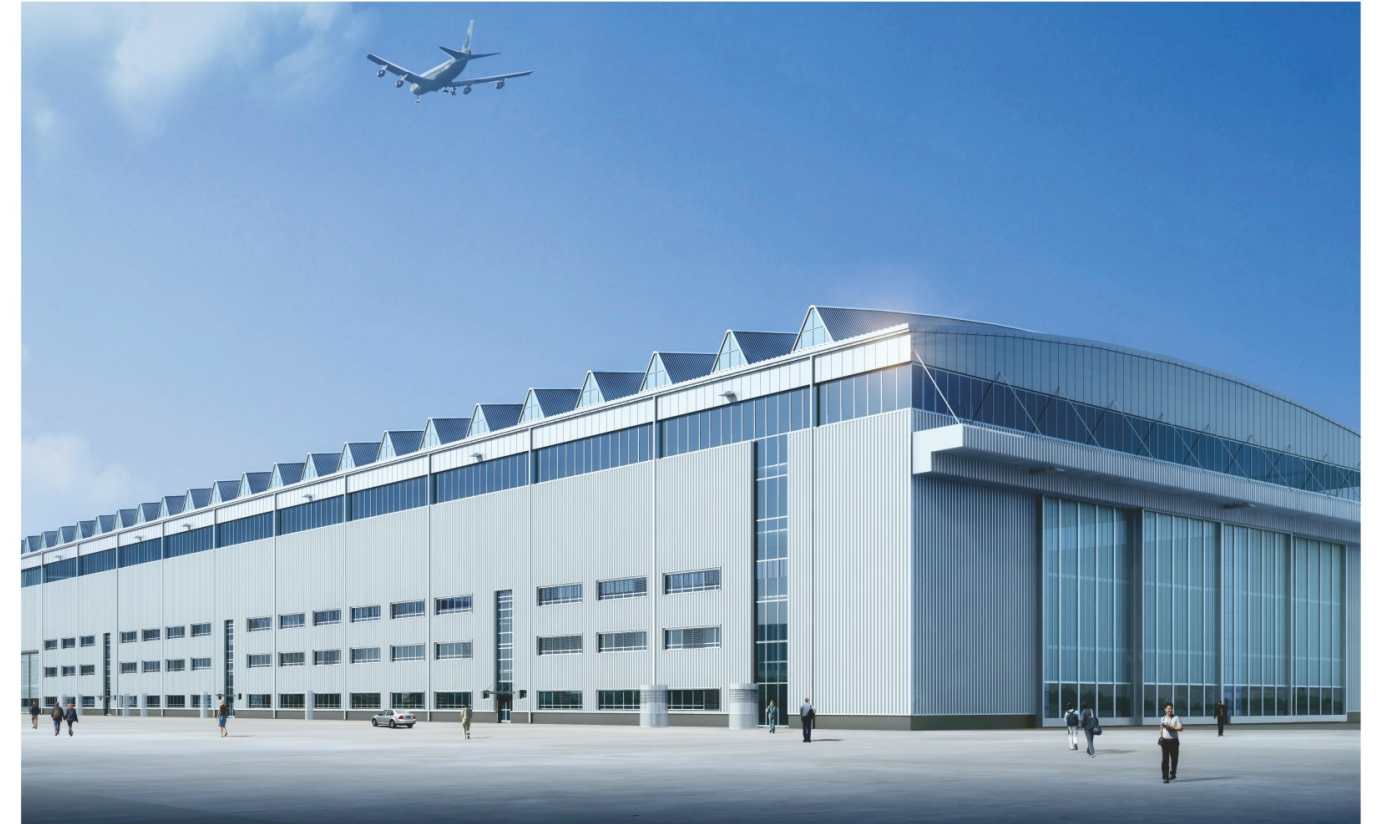
空客A320天津总装线厂房工程 Airbus A320 Tianjin Assembly Line Plant
