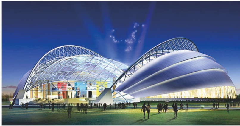
沈阳奥体中心体育场 Shenyang Olympic Sports Center
